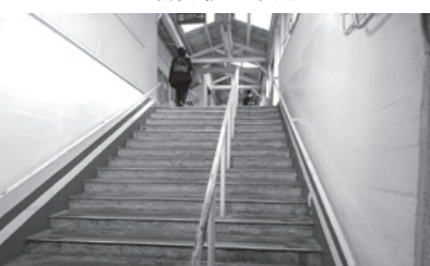
地下道への階段
